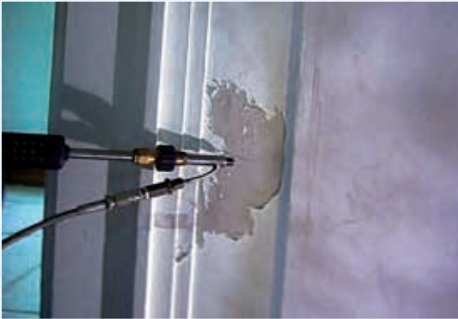
Restauration, Denkmalpflege und Wand-Decken-Sanierung.
