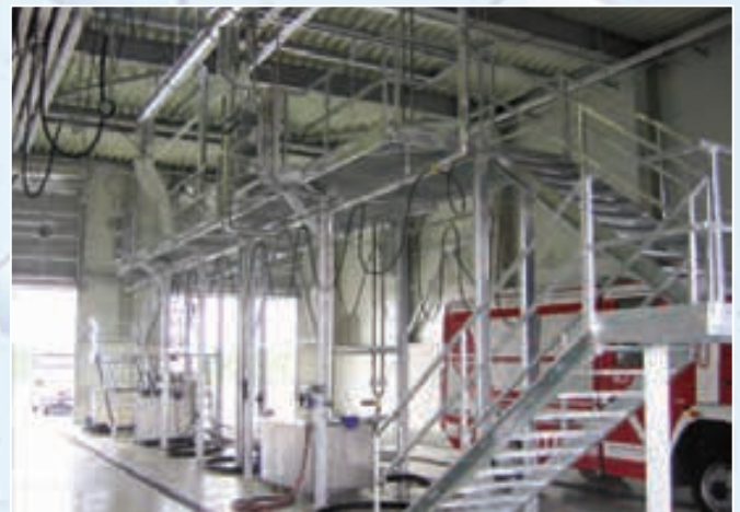
Tankinnenreinigungsstation für Tank- und Silofahrzeuge und Tankcontainer in einem Cargo Center.
