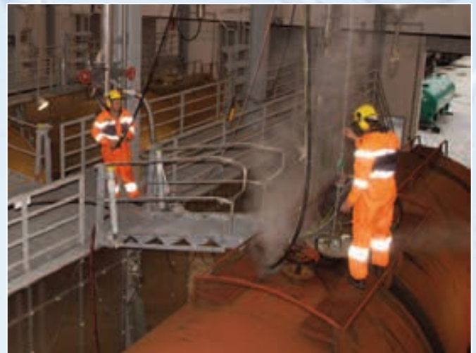
Eisenbahn-Kesselwaggon bei der Tankinnenreinigung.
