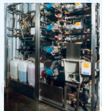
4-Pumpenanlage mit unterschiedlichen Dosiersystemen.
