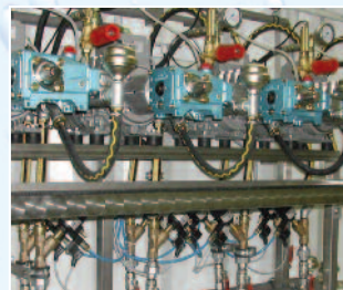
Hochdruckpumpenaggregate für Hochdruckreinigung.
