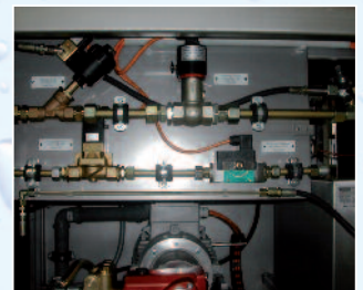
Steuer- und Regelelemente einer Reinigungsanlage.
